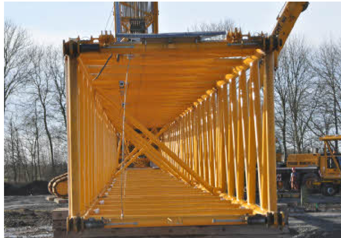
Direkt neben der B 5 soll die Nordex mit 3,3 MW-Leistung errichtet werden. Dieser Tage wurde der große Montagekran vor Ort zusammengebaut.
