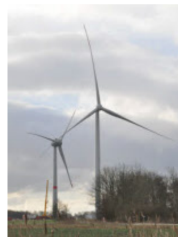
Die Enercon- (l.) und die Siemensanlage im Testfeld.
